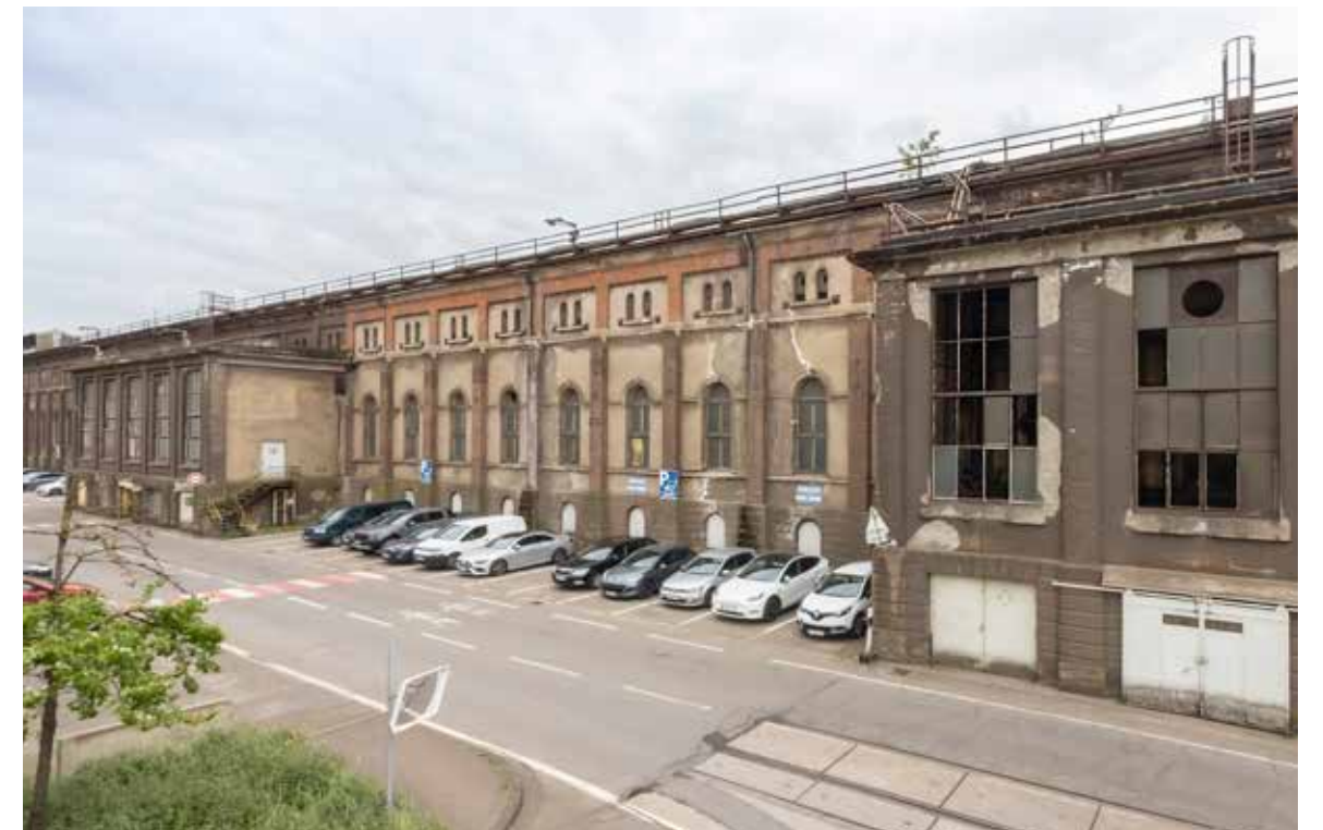
Le bâtiment de la centrale à gaz repose sur un socle extérieur en maçonnerie en moellons, remontant jusqu'au premier niveau. Les murs et les piliers ascendants sont en briques rouges et en maçonnerie. Chaque trame de la façade est composée d'une fenêtre au niveau de la rue, d'une taille plus importante au premier niveau et de deux baies jumelées de taille réduite au niveau supérieur, avec des créneaux sous la corniche.
