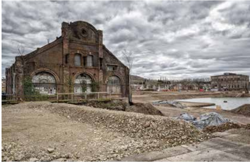
La halle de coulée a été construite vers 1900 en briques rouges. Dans la façade du mur sud-ouest, des vestiges de la première halle de 1871 sont toujours présents. La halle des soufflantes, en arrière-plan, a été construite à la fin des années 1930 et abritait les machines à gaz.
