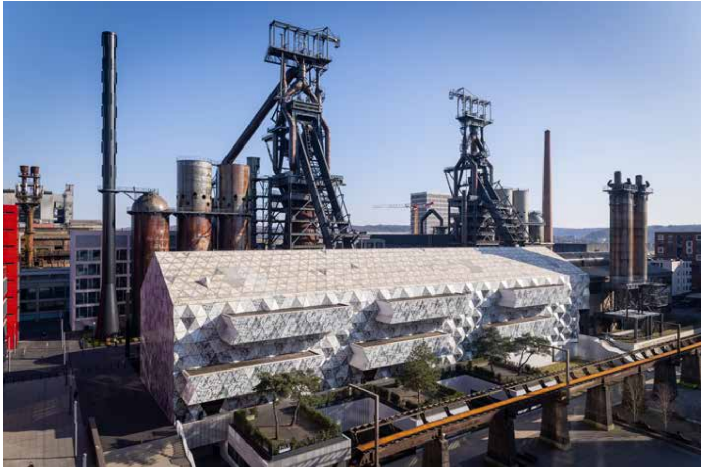
Les hauts fourneaux A et B, ensemble avec la halle de coulée, dite « Möllerei », les cowpers, la cheminée en briques et la tuyauterie forment la silhouette patrimoniale d'Esch-Belval.
