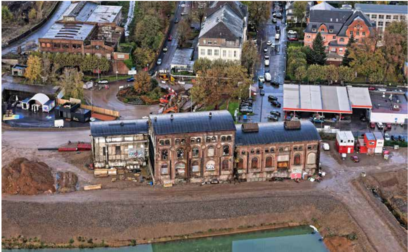
Datant en partie de 1895, ces halles ont été modernisées à plusieurs reprises jusqu'à la fermeture de l'usine en 1977.
