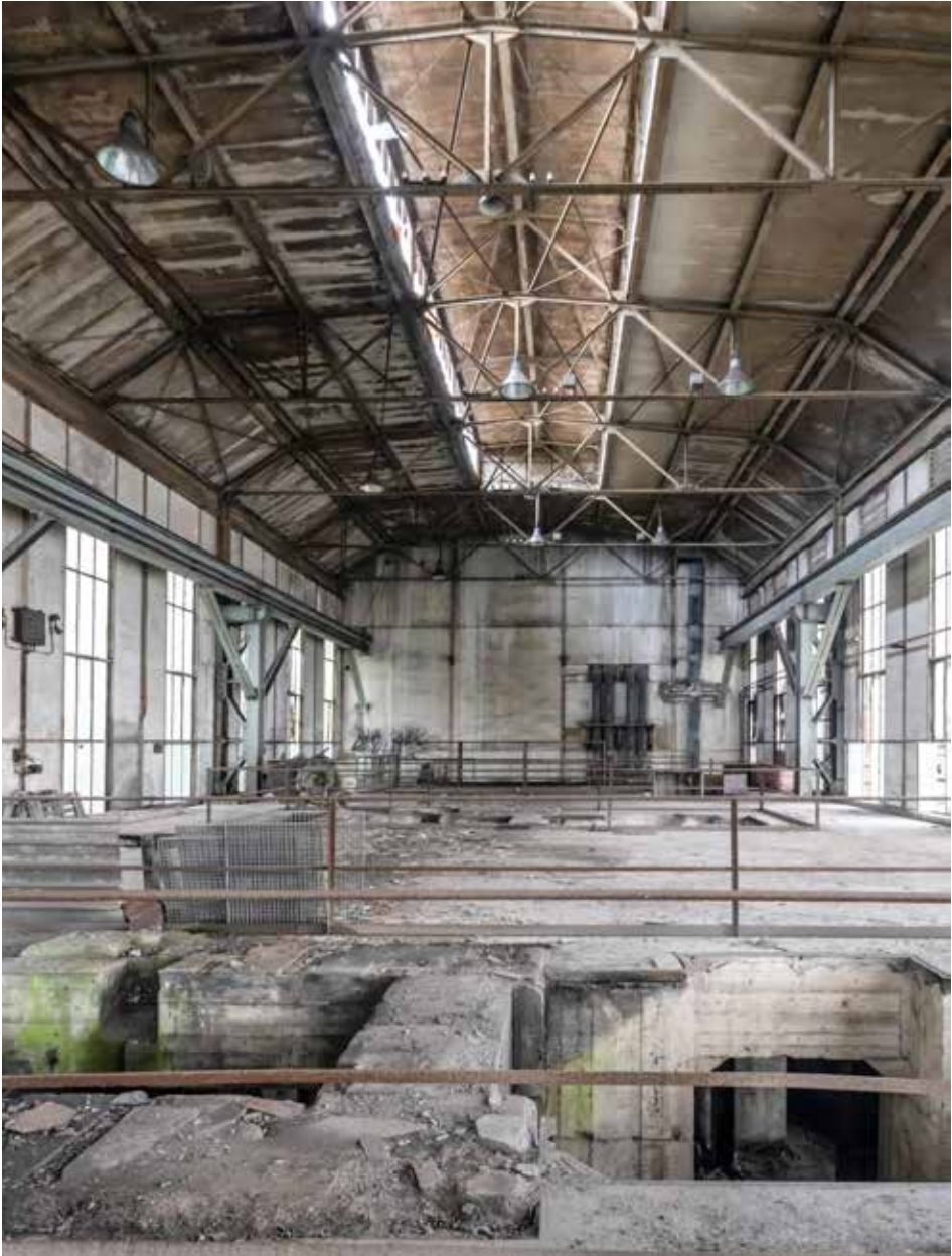
Le bâtiment de la centrale thermique a été construit en deux phases entre 1952 et 1958. La centrale produisait de la vapeur sous pression utilisée dans deux turbines. Cette technologie, qui a succédé aux moteurs à gaz, fournissait de l'électricité jusqu'en 1997.
