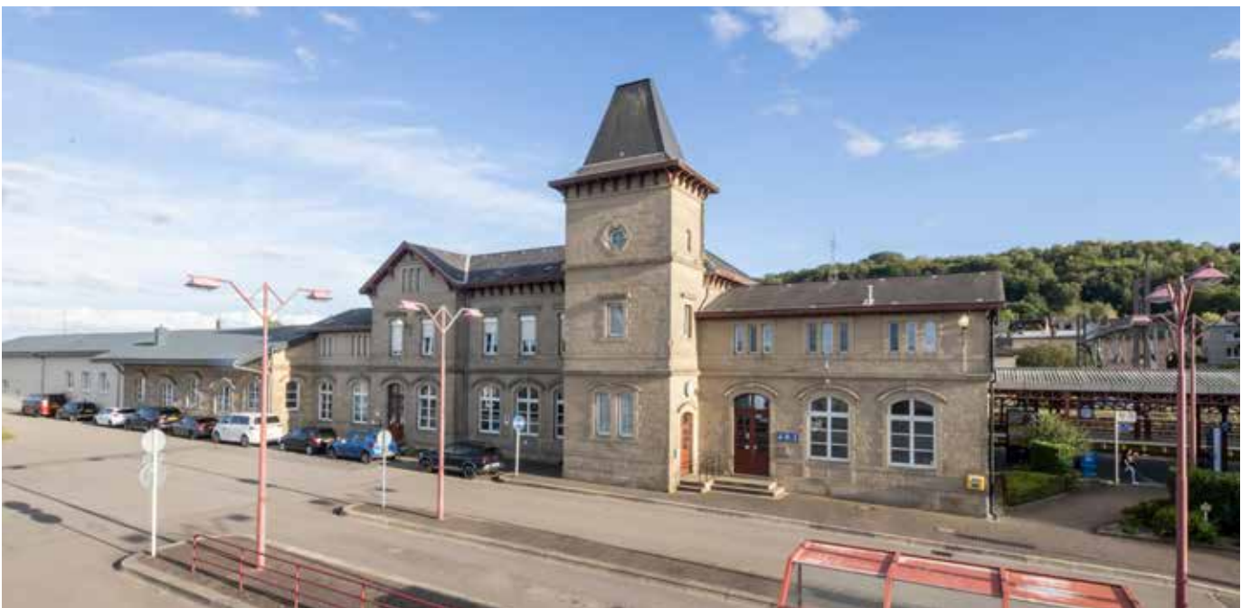
Le bâtiment représentatif de la gare de Pétange a été construit en 1900 par la Compagnie des Chemins de fer Prince Henri, remplaçant un édifice de 1873. Étant donné que Pétange était le siège de direction de la compagnie, un bâtiment prestigieux fut érigé.
