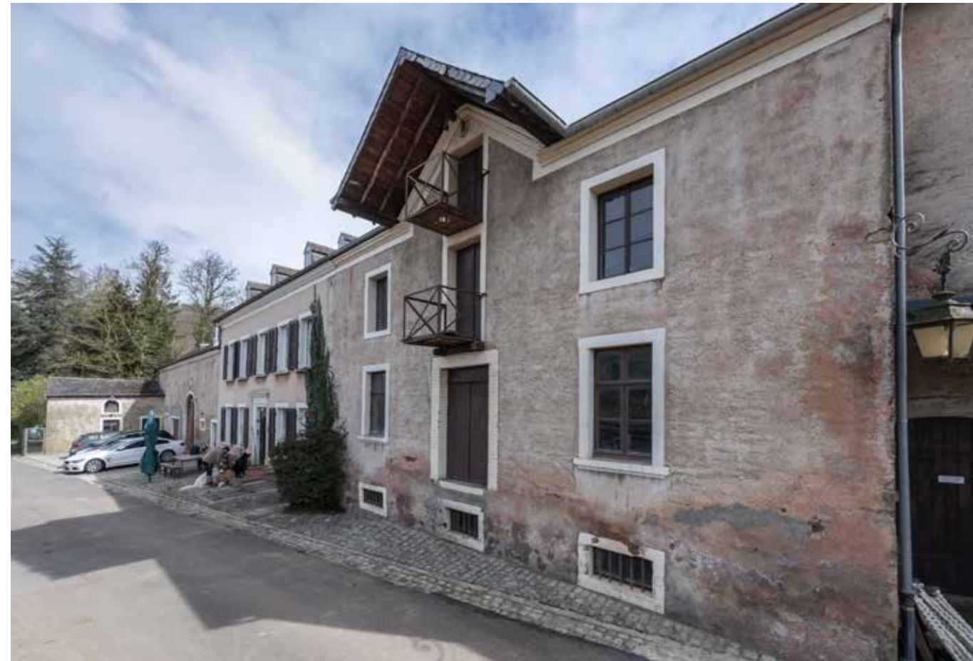
La fonction initiale du moulin à huile d'Essingen, dont les origines remontent à 1531, a été abandonnée dans les années 1930, lorsqu'il fut transformé en centrale électrique. À partir de cette période, seule une petite quantité de farine et de fourrage pour le bétail était moulue sur place, jusqu'à l'arrêt définitif des activités en 1948.
