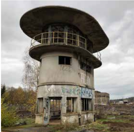
À l'extrémité sud du site, à la frontière française, se trouve le poste d'aiguillage construit en 1950. Avec ses angles arrondis, typiques de cette époque, et son plan allongé et étroit, cet ouvrage constitue un bâtiment emblématique du site.
