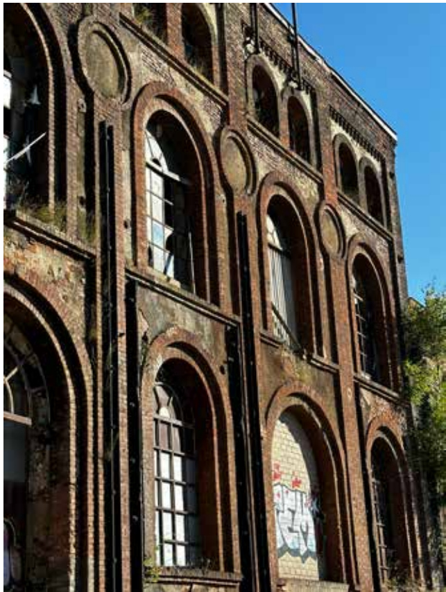
Le complexe de bâtiments situé à l'extrémité est du site se compose de plusieurs halles et annexes, construites en différentes phases. Elles abritaient les machines à cylindres à gaz destinées à la production d'électricité et de vent.
