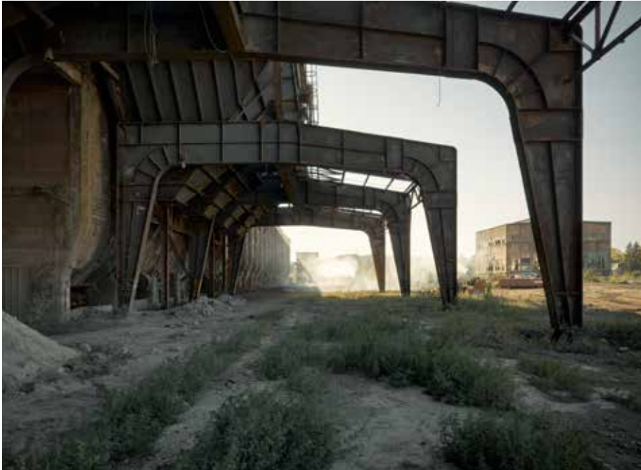
La structure en acier des Keeseminnen est intégrée au nouveau quartier.
