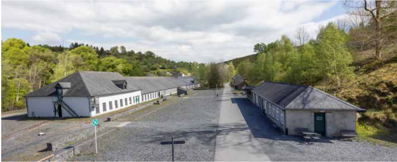
L'atelier des fendeurs de la carrière Johanna (à gauche) fut érigé vers 1900 pour le fendage des blocs de pierres et la taille des ardoises de toiture. Jusqu'à 120 personnes y travaillaient ensemble, appelées « Leekëpperten », qui taillaient jusqu'à 12 mio d'ardoises par an.
