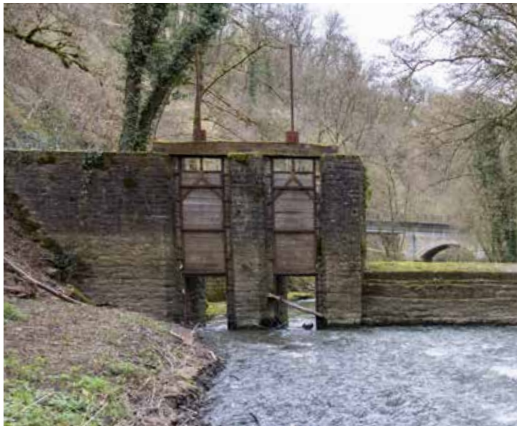
Le barrage, composé de deux passages voûtés verticaux et d'une imposante muraille, dirigeait l'eau vers le canal du moulin de 850 mètres et la faisait passer sous le pont ferroviaire jusqu'à l'aqueduc. Le moulin, l'aqueduc, le barrage et le canal de la papeterie Lamort à Manternach avaient été réaménagés par le producteur de fer Léopold Joseph Fabert. (double page précédente)
