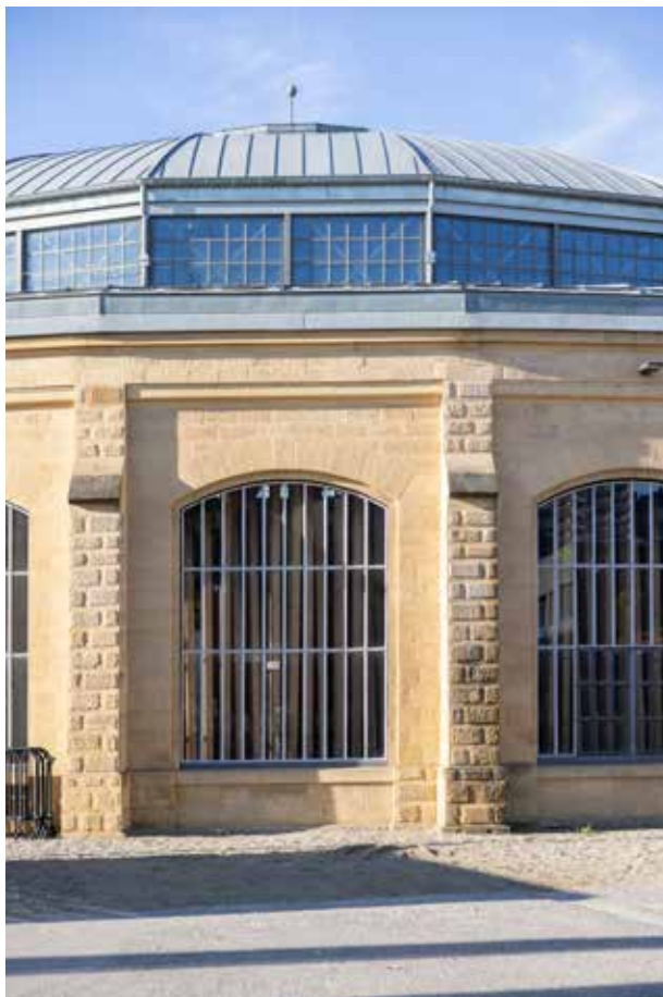
La maçonnerie en pierres de taille affiche une expression monumentale, rythmée par de grandes baies pourvues de fins châssis en acier.
