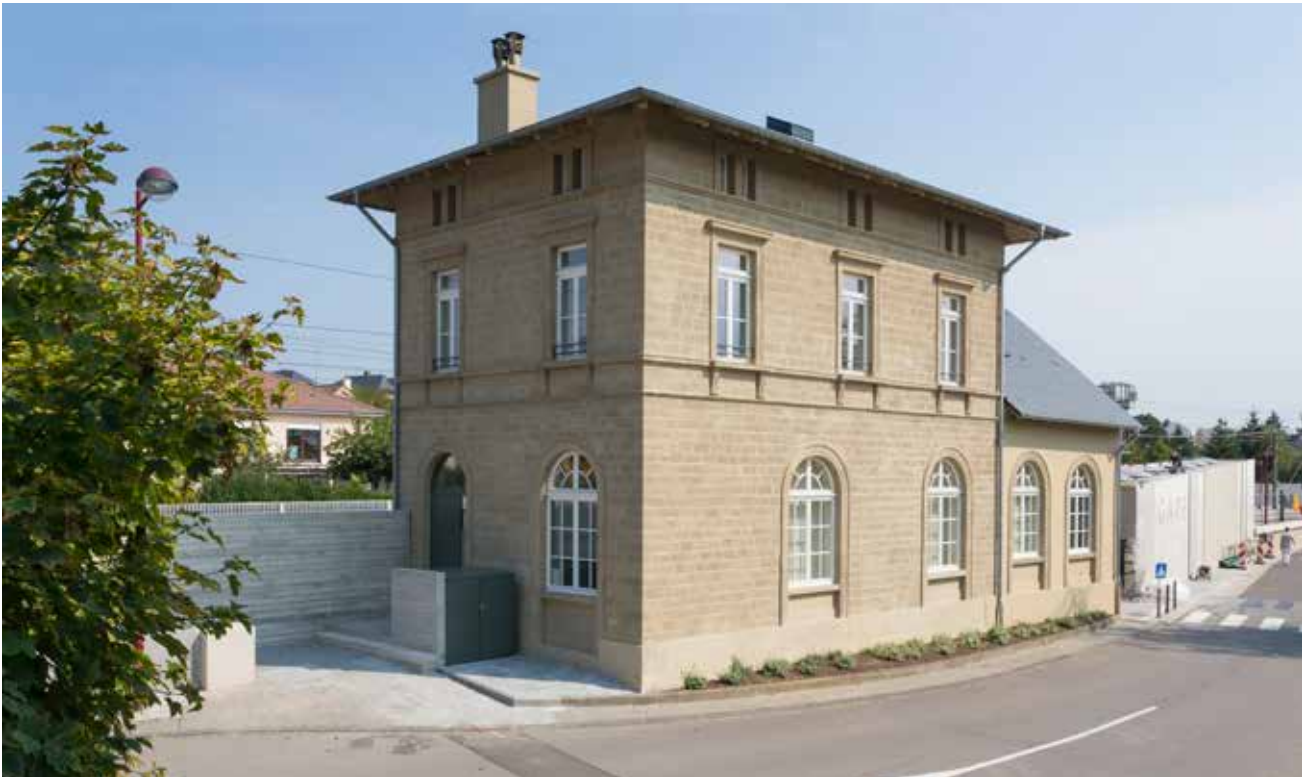
Le bâtiment voyageur de la gare de Noertzange a été construit en 1873. Remise en valeur par le SSMN dans un souci de respect envers sa structure d'origine, la gare sert aujourd'hui de résidence pour des étudiants et chercheurs.
