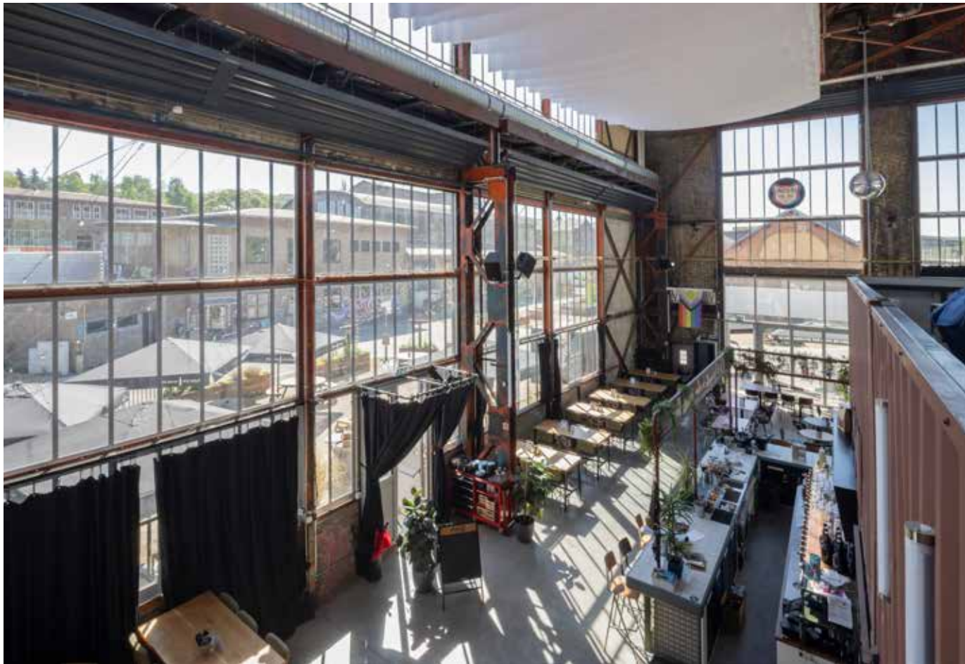
L'atelier des locomotives construit autour de 1950 a été restauré par la commune de Dudelange, en collaboration avec l'INPA, et une brasserie y a été installée. Haute de 15 mètres, la halle fut construite sous une charpente métallique avec des briques de laitier générées en tant que matière minérale artificielle lors de la production de l'acier. À côté de cette halle, le bâtiment social avec atelier fut réaménagé à des fins socioculturelles.
