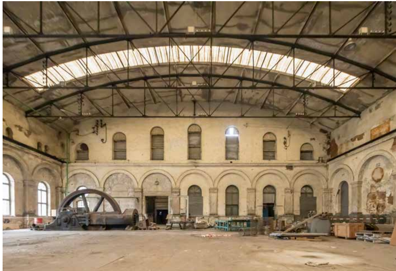
La toiture en voûte de la centrale à gaz, alternant des éléments en verre translucide et reposant sur une charpente métallique filigrane, apporte la lumière naturelle et offre une large perspective. L'architecture de pilastres avec base et chapiteau suivie d'un arc en demi-cercle reflète le style de l'époque. La surface intérieure entre le sol et l'allège est décorée de faïence composée de bandes géométriques. Les différentes travées du plafond ont été coulées sur place en béton léger armé de fer. L'empreinte négative du coffrage en bois est encore partiellement visible sur la face inférieure du plafond.
