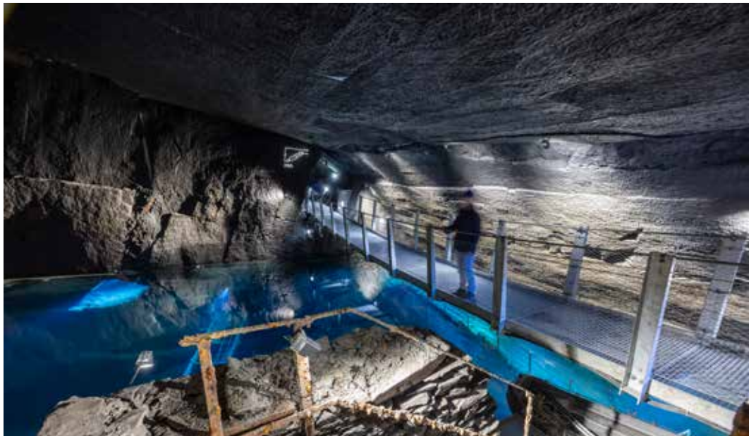
Passage à -42 m de la chambre 18, la plus grande du site (95.000 m 3 d'ardoises extraites). Avec un pompage permanent, le niveau de l'eau est stabilisé à -42 m. En 2024, 168 mio de litres d'eau ont été pompés. Sous la surface de l'eau, d'anciennes passerelles et escaliers historiques sont visibles grâce à un éclairage spécial, page 93.
