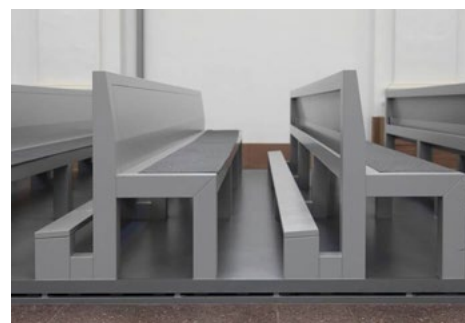
Allemagne: bon exemple: l'air chauffée sur les chiens assis est ventilée dans le nouveau mobilier creux qui sert à donner du confort aux gens qui s'assoient et de la chaleur à l'édifice
