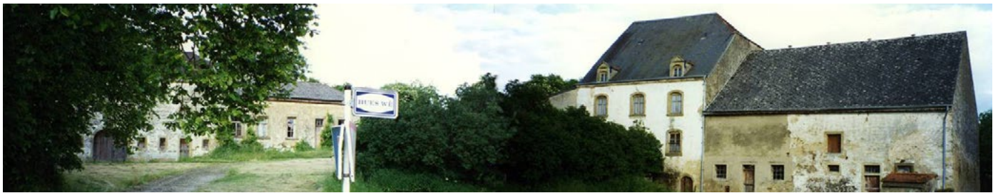
lechternacherhaff à Eschweiler avant restauration
