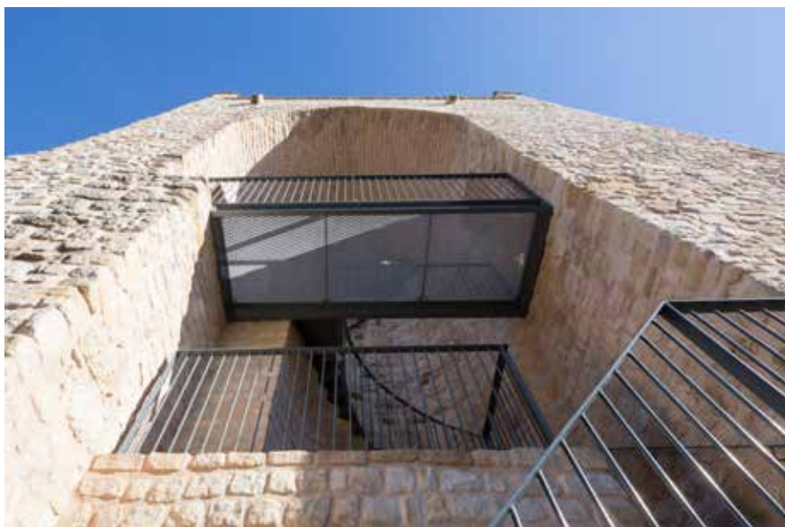
La tour médiévale à côté de la Dënselspaart comportait en sa partie supérieure des escaliers maçonnés d'origine tandis que la partie inférieure de la circulation verticale avait disparu. Avec l'installation d'un escalier contemporain, l'entièreté des niveaux est redevenue accessible.
