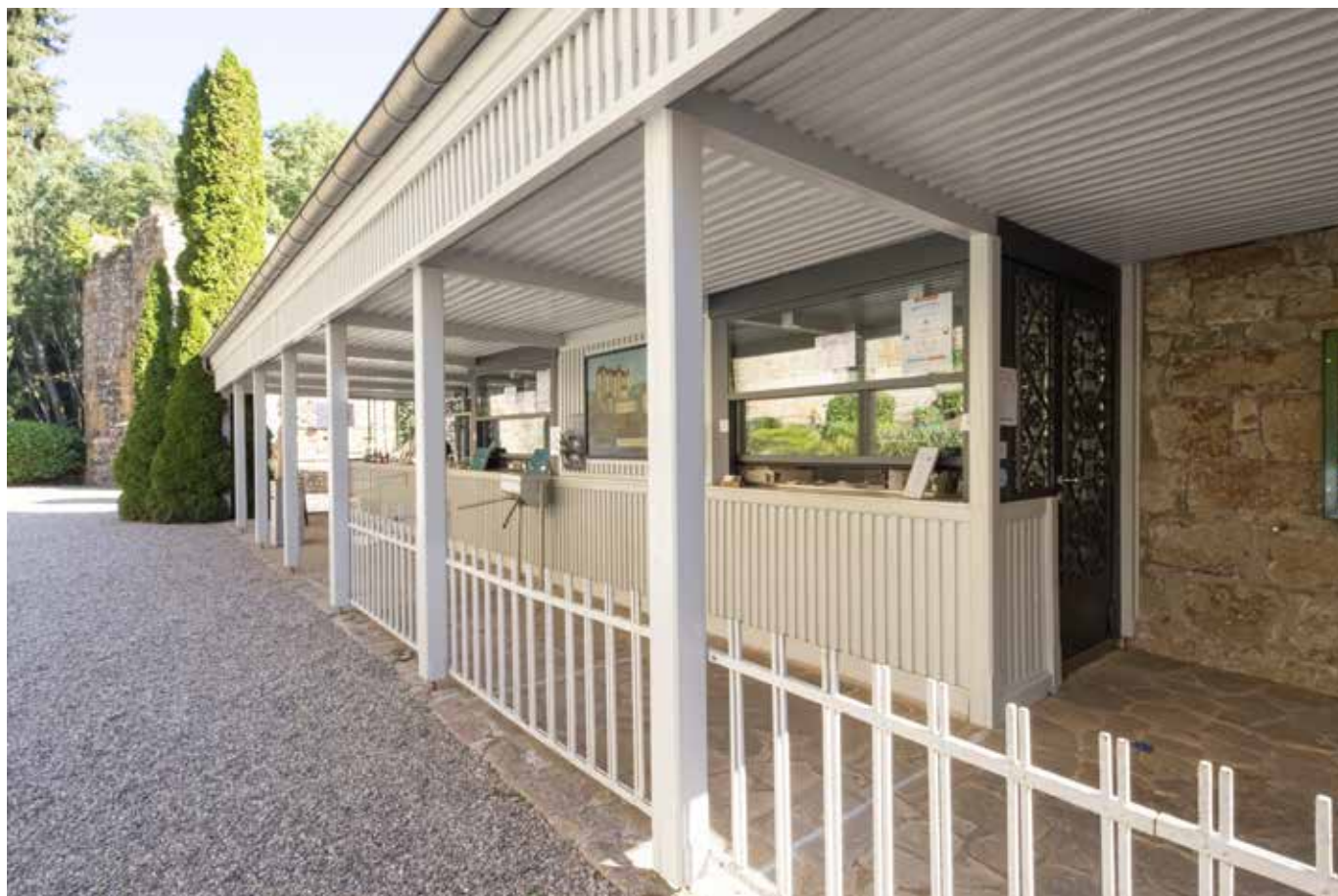
Située dans la basse-cour du château fort, une structure en bois des années 1930 sert d'accueil et de point de vente et de dégustation. Le pavillon a été modernisé et une cuisine y a été installée pour le personnel.
