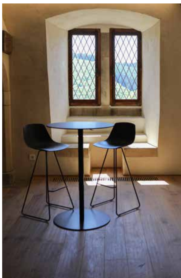
Un enduit à la chaux a été appliqué aux murs ayant connu une restauration élémentaire à partir de 1972. Un système de chauffage d'appoint par convecteurs intégrés dans le plancher en bois crée un écran d'air chaud devant les fenêtres.
