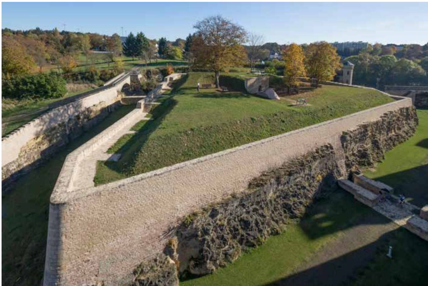
L'accès unique vers le ravelin se fait par un long escalier en continuation de la caponnière. En haut, le visiteur se retrouve sur un belvédère, qui propose des vues lointaines. Sur le côté gauche, on reconnaît la contrescarpe de l'ouvrage.
